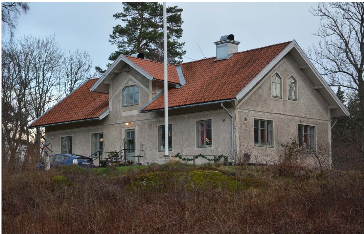
Tegelhagens gård, fd arrendatorsbostaden
