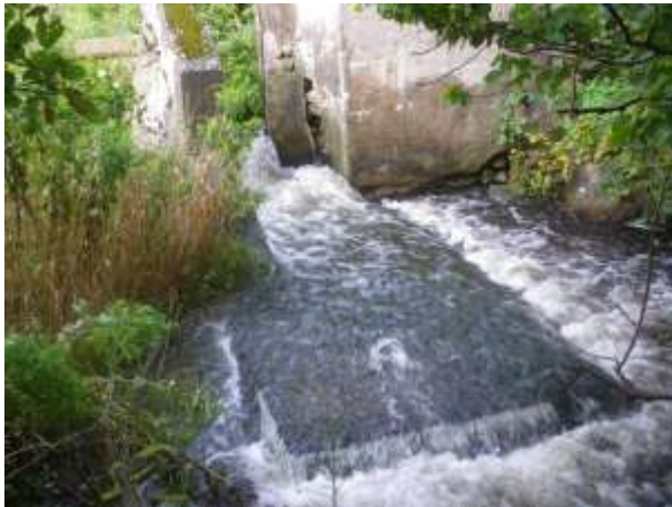
Vandringshinder som ska rivas
