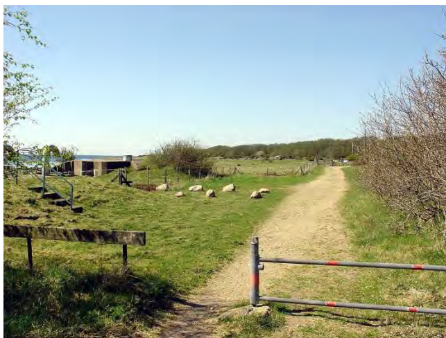
Avloppsreningsanläggning i skötselområde 14. Foto 2006-05-09.
