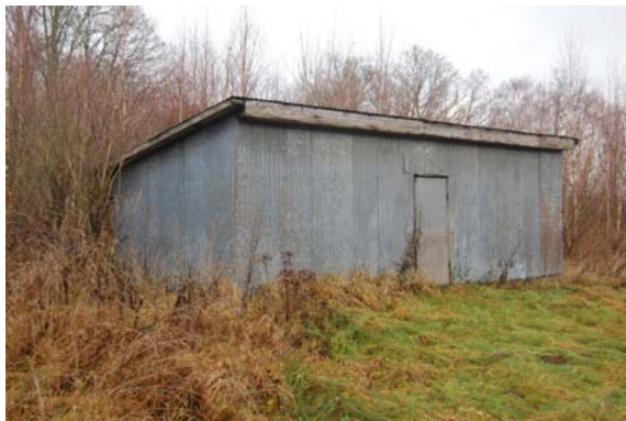
Plåtförrådet som ska tas bort
